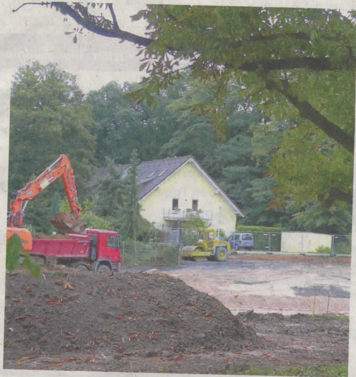
■ Endlich bewegt sich etwas im „Sträterschen Park“: die Bagger und LKW rollen. FOTO: GAST
